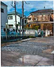
◎月極駐車場に砂利をひき 水たまりを避ける
