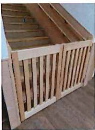
◎階段転倒防止柵 内倉庫内に柵を作成
