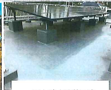
屋上防水塗装工事
